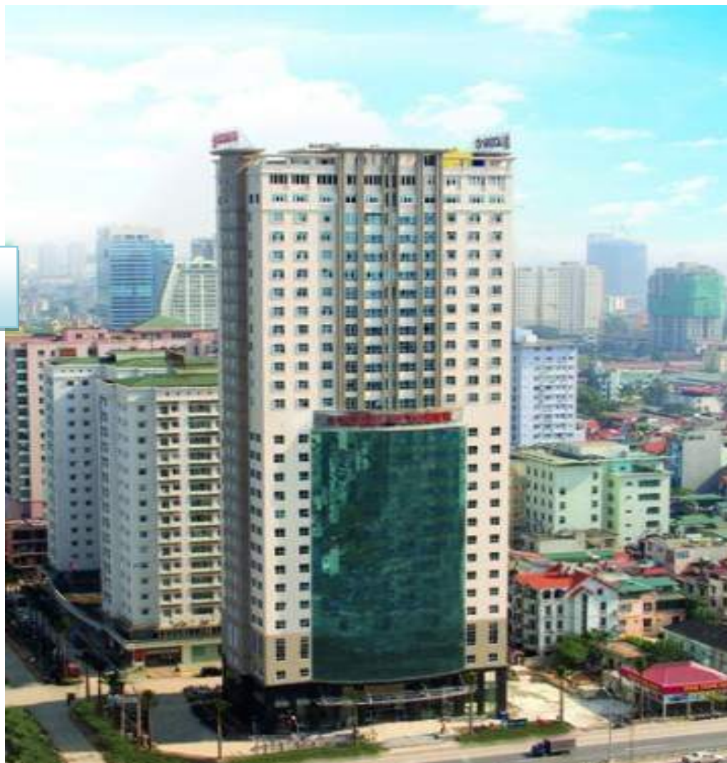
TÒA NHÀ LICOGI 13
